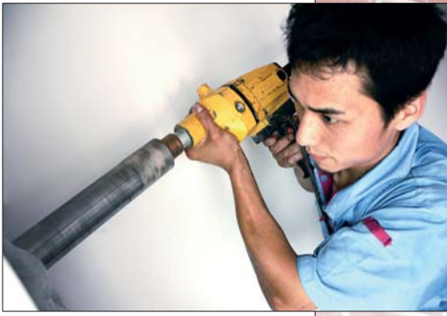
在墙壁上钻孔。
