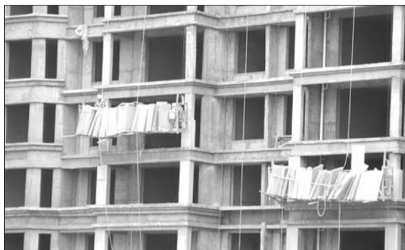
21日中午11时许,建筑工人还在高温天气下施工。
