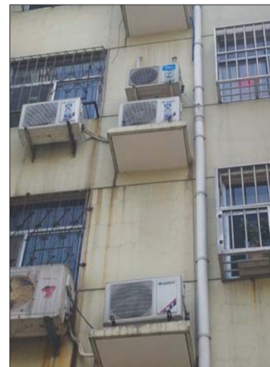
在一些老旧小区,空调排水管多随意放置,还有些空调未安装排水管。 本报记者 张召旭 摄
