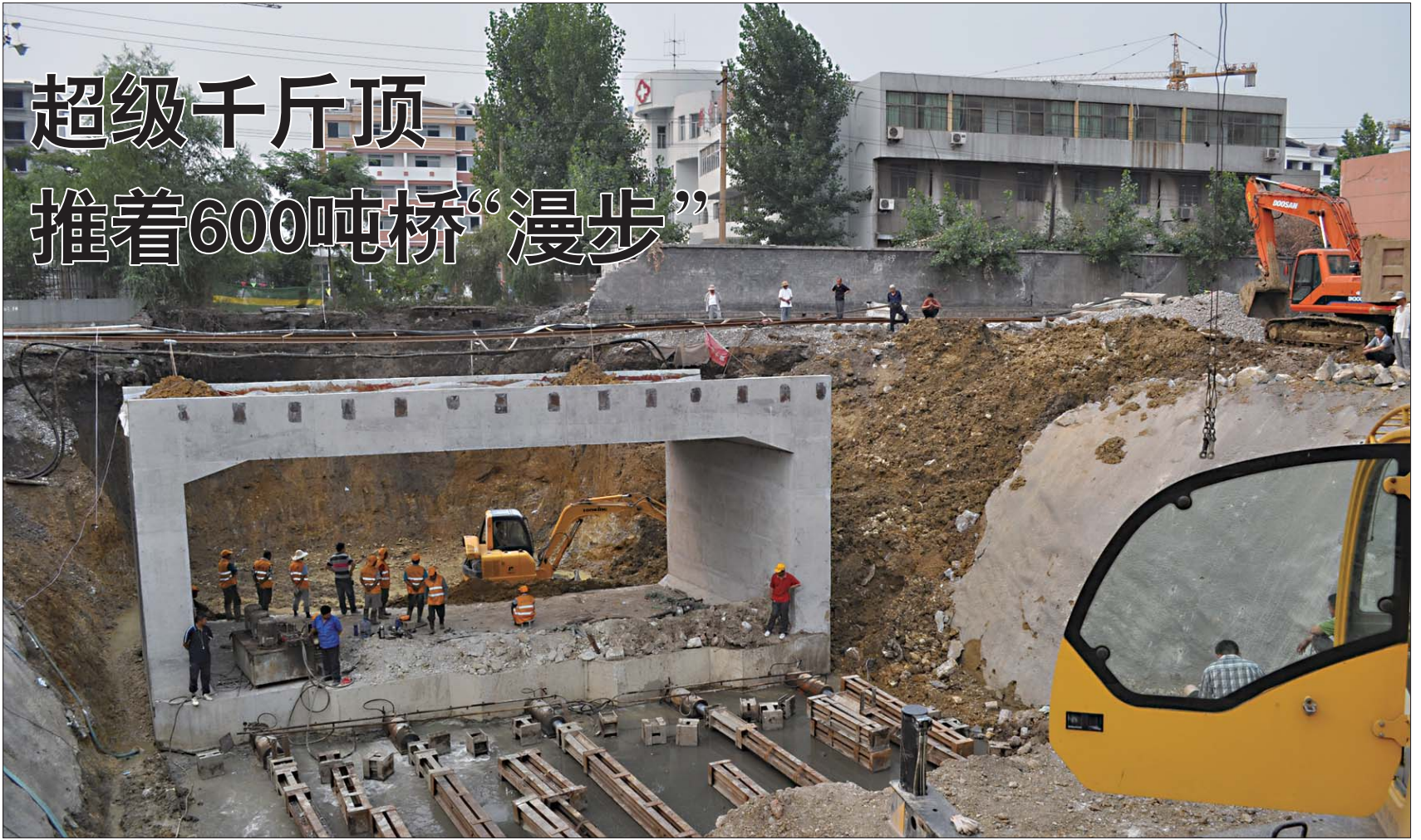
6月23日傍晚20时36分,市中区长青路箱形桥平稳就位,“平改立”改造箱形桥主体工程顶进工作圆满完成,标志着市中区段第一座箱形桥顶进工作进展顺利。 本报记者 李泳君 本报通讯员 曹建明 付小春 摄影报道
