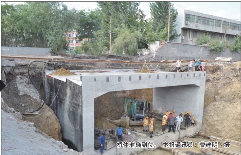
5个200吨的顶柱推动桥体。 本报通讯员 曹建明 摄
