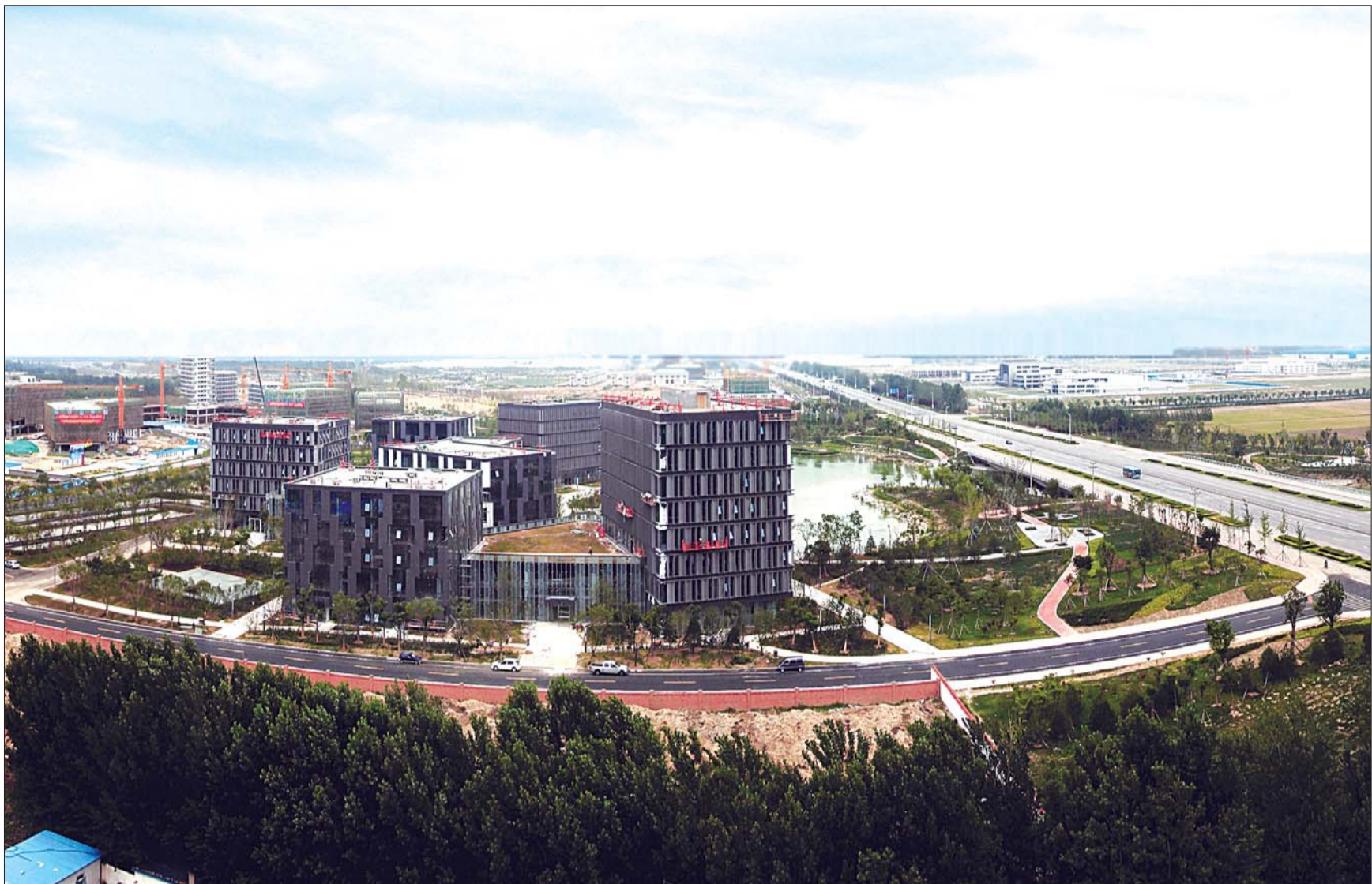
正在建设中的东部创新创业区。
