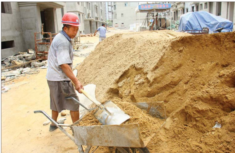
25日,在聊城市区一处工地,一位工人在冒着高温装沙子。
