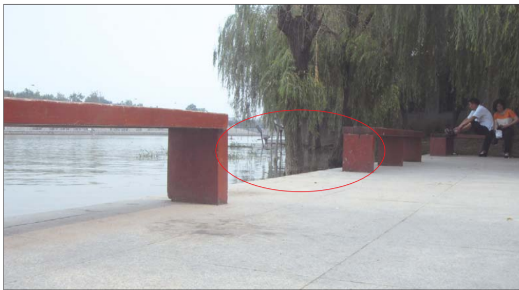
新天地公园河畔部分板凳丢失,不知道谁下的黑手。记者 张歆然 摄
