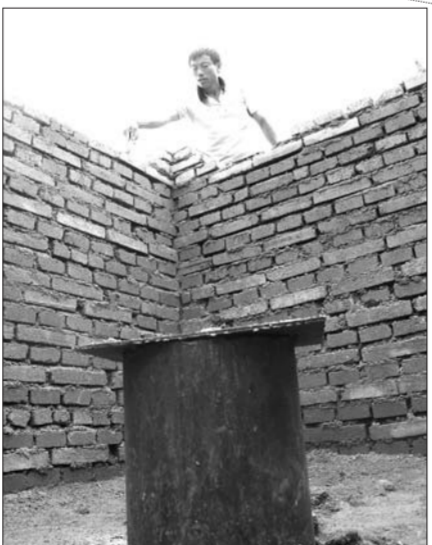
大桃园村的村民在给刚刚打好的机井修筑水房。 本报记者 刘涛 摄
