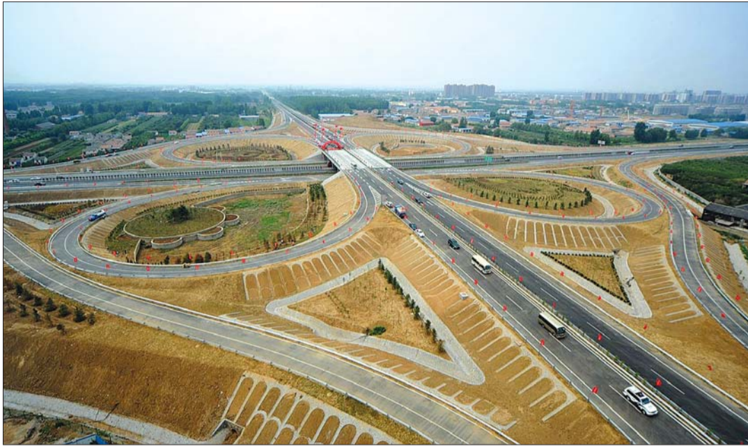
冯家庄立交桥正式通车。本报记者 王世腾 摄
