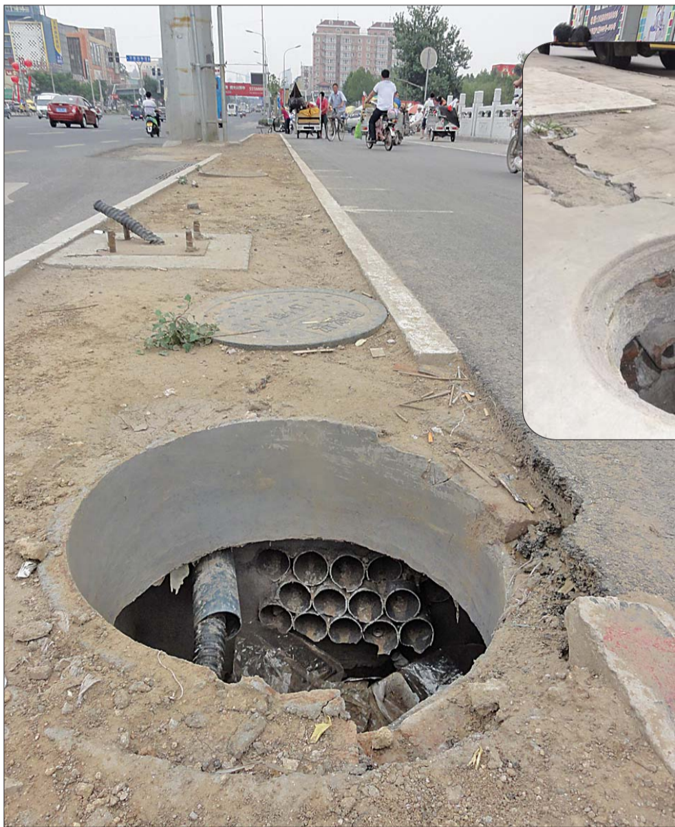
拍摄地点:二环北路百通物流门口,高架桥下 拍摄人:李先生 拍摄时间:6月26日 说明:一个井盖缺失。
