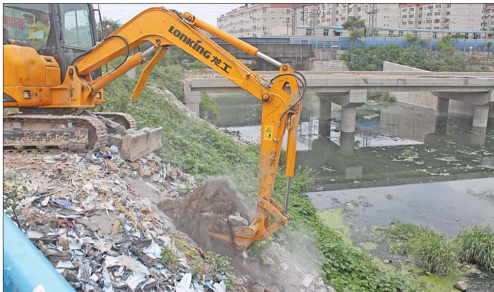
▲天桥区工商河引河凤凰山段开始清淤,这是挖掘机在清理岸边的生活垃圾。 本报记者 董从哲 摄
