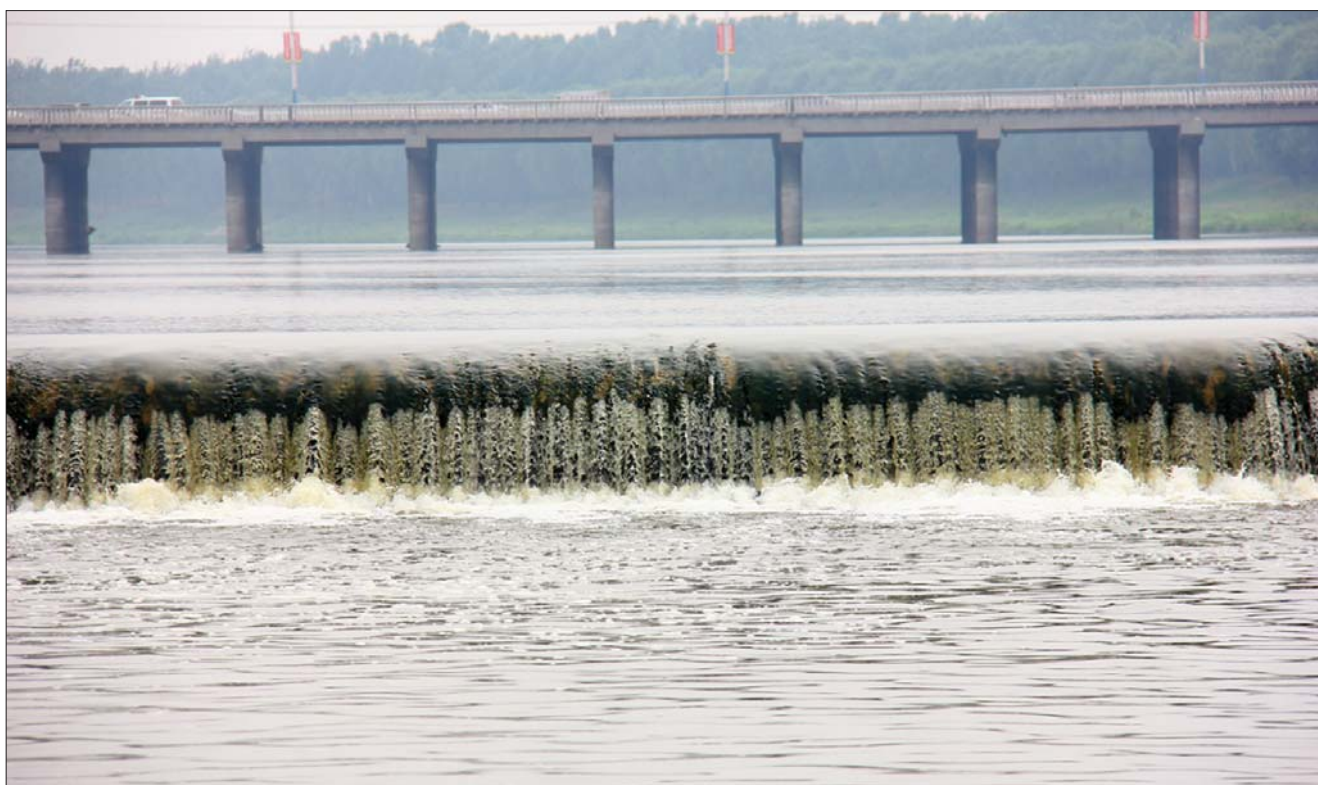
位于聊城城区东郊徒骇河干流上的橡胶坝,集蓄水、城市防洪、旅游开发等多功能于一体。(资料片)本报记者 邹俊美 摄
