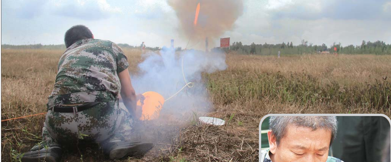
抢修人员正在使用抛绳器将光缆运送至河对岸。
