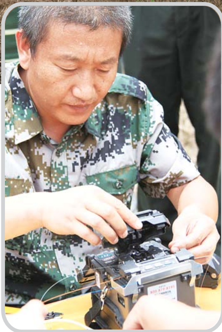
抢修人员进行光纤熔接,额头上挂满了汗珠。
