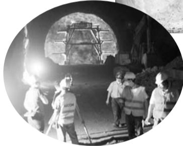
▼在施工处,中铁十七局工作人员正在隧道内标线测量,以便正确安装炸药。
