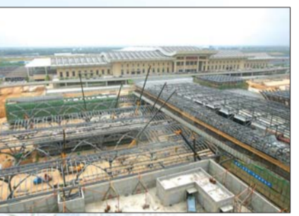
▲济南西站东广场正在紧张施工。 本报记者 杨宁 摄
