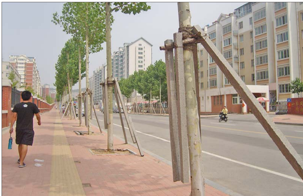
不少树都挂着两三根断掉的水泥支撑柱。
