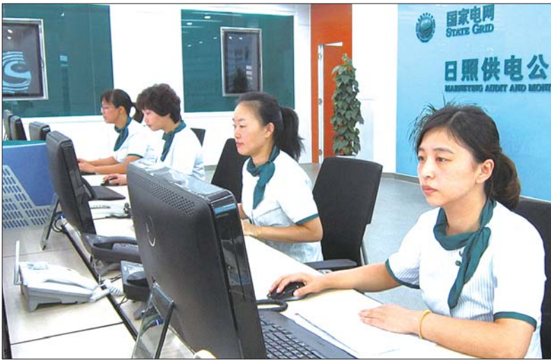
2日下午,日照供电公司95598远程工作站的工作人员正在实时监控居民用电情况。 本报记者 李玉涛 摄
