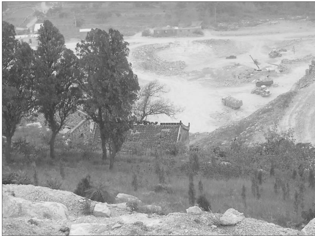
采石场的工人正在施工。
