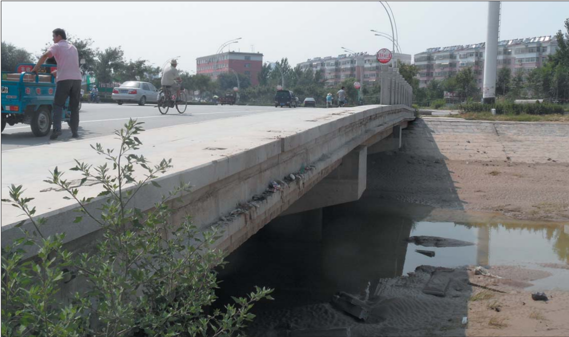
桥护栏缺失,坏掉的护栏散落在桥下。 本报记者 任洪忠 摄
