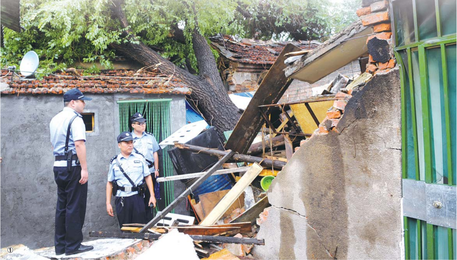
1 4日下午2时许,历下区万寿宫路6号院内一棵有60年树龄的大树被大风刮倒,砸塌了一间厨房,损坏多间房屋,所幸没有人员伤亡。 本报记者 张中 摄
