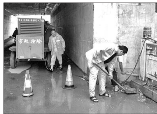
市政工人用移动机组排水。
