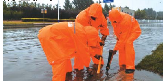
烟台市莱山公路管理局养护人员坚守一线,挖除淤积物,疏通排水管,清理积水,确保辖区全路段安全畅通。通讯员 迟恒 记者 李大鹏 摄
