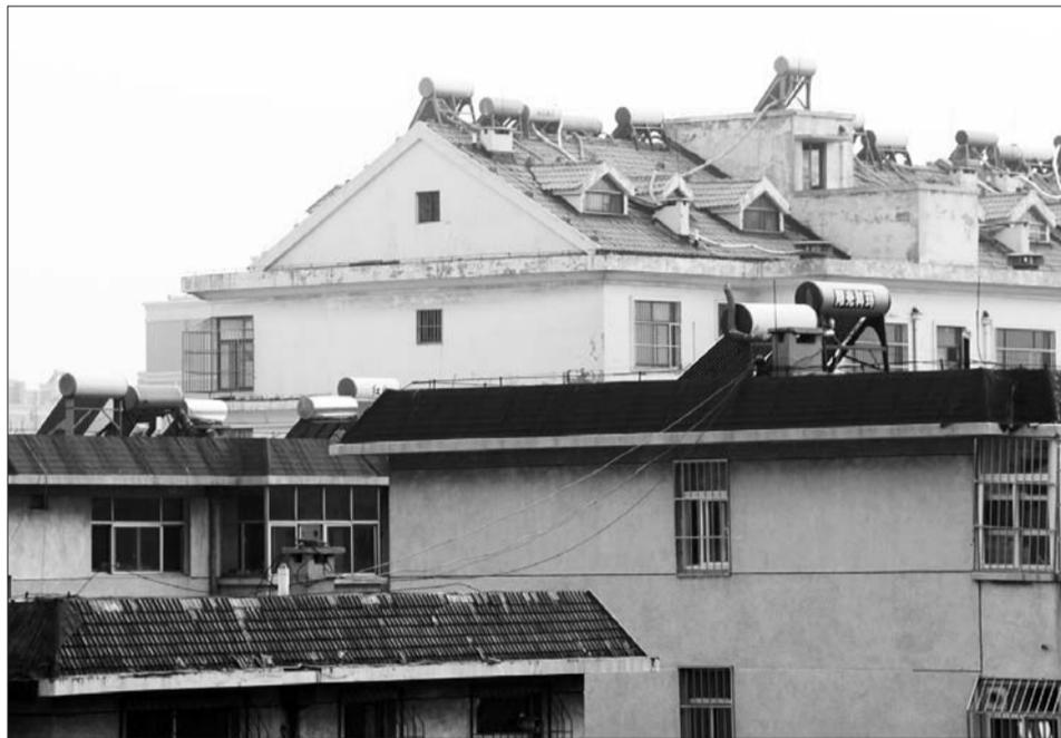
小区楼顶杂乱的电线随意地搭放在避雷设施上,在雷雨季节极易发生雷击事故。本报记者 马志勇 摄
