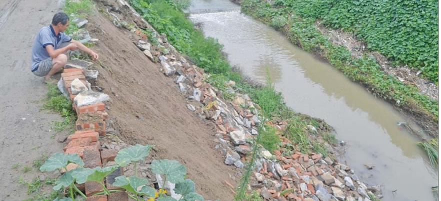
▲泄洪沟东侧挡墙塌陷的面积较大,砖头和石块都堆在了泄洪沟底部。 本报记者 赵伟 摄
