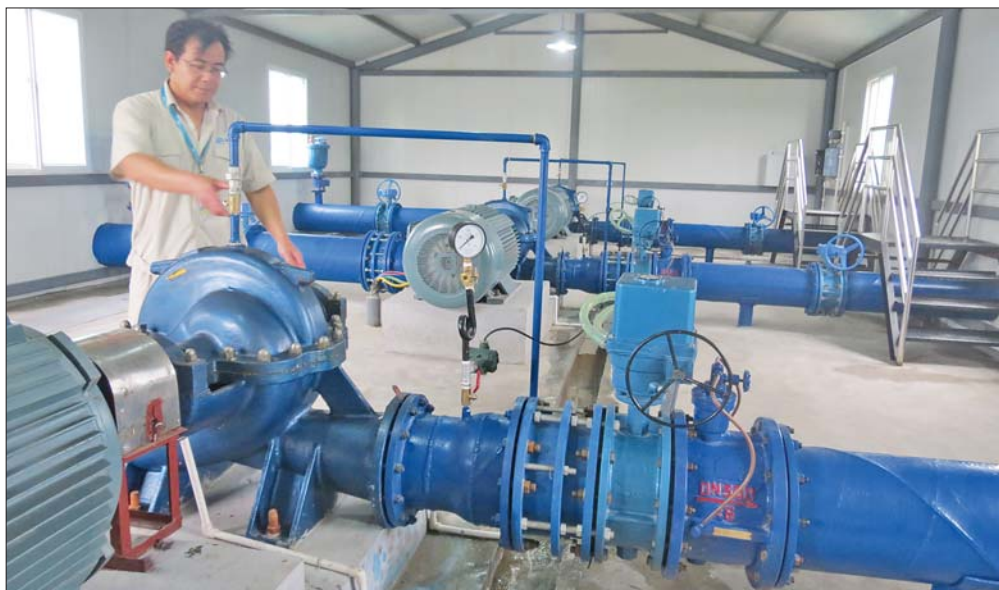
10日下午,济西地下水输送至临时加压站。 张文 摄
