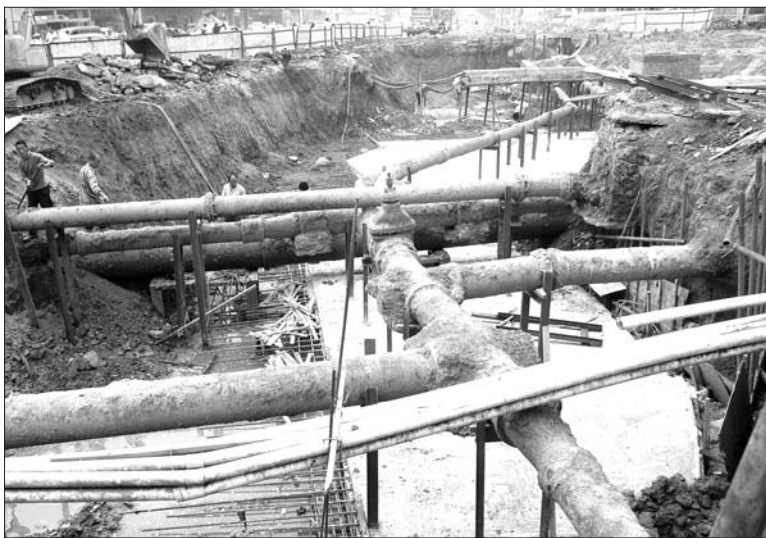
一些路段,地下管线错综复杂。通讯员 张明华 摄
