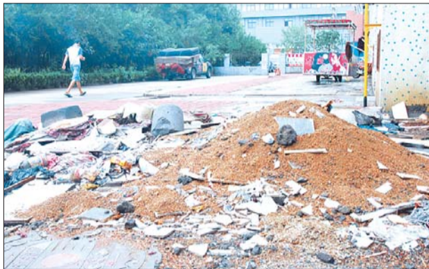
沂州路一小区内楼道口堆放着很多杂物。
