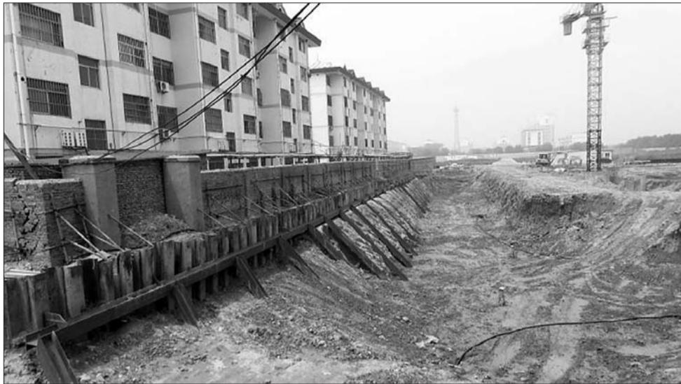
小区院墙因地基不稳发生倾斜,墙体开裂,施工方在外面用支架将墙体撑住。
