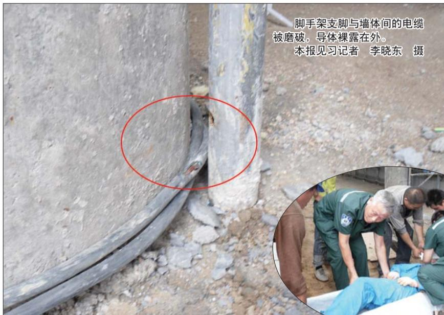
脚手架支脚与墙体间的电缆被磨破,导体裸露在外。
