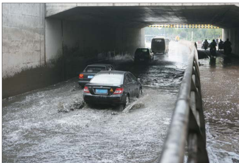
11日,在潍坊市春鸾路铁路桥下,经过一阵降雨过后桥下又有了少量的积水。与往年降雨过后春鸾路铁路桥出现严重的积水情况相比,经过改造后的铁路桥下只是少量的积水,并没有给过往车辆造成太多的影响。
