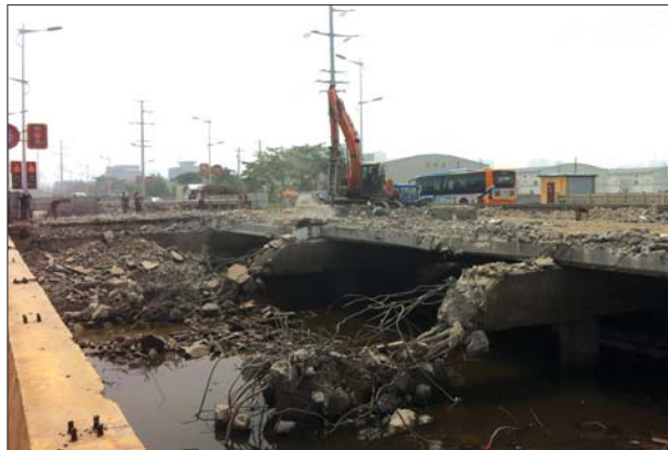
11日,聊堂路沟大桥已经进入拆桥重建阶段。去往冠县、莘县的车主,可绕行湖南路。 本报记者 刘铭 摄
