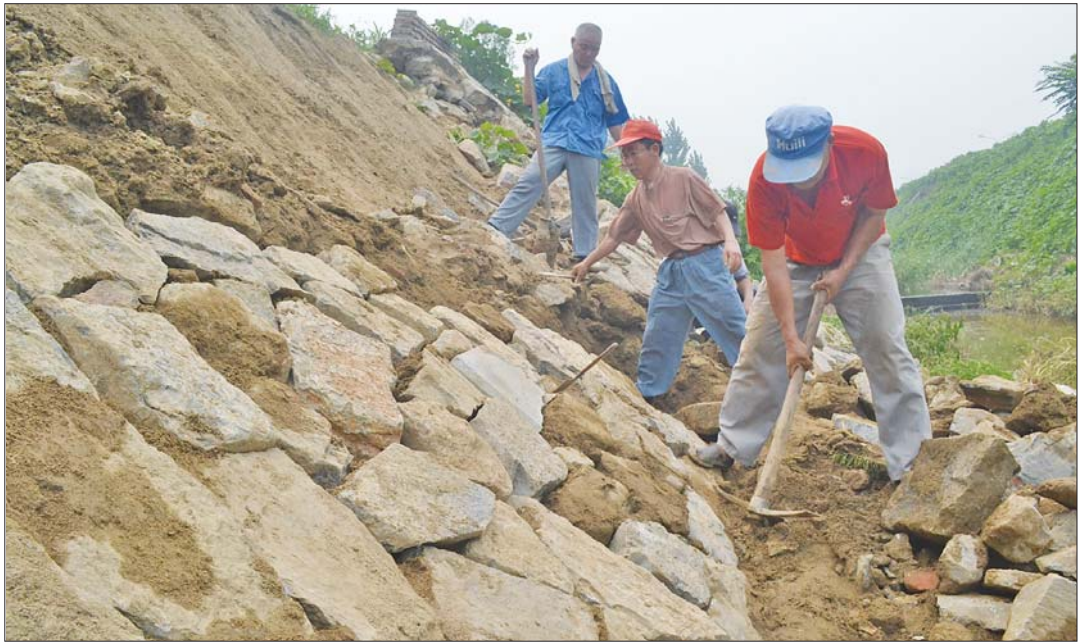
施工人员正在对塌陷的护坡进行修复。 本报记者 赵伟 摄
