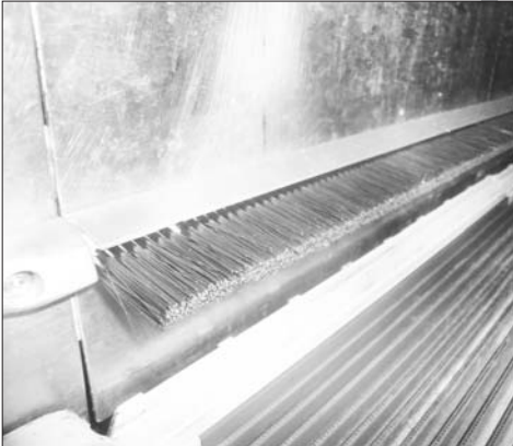
安装了围裙板防夹装置的电梯,安全系数增高。
