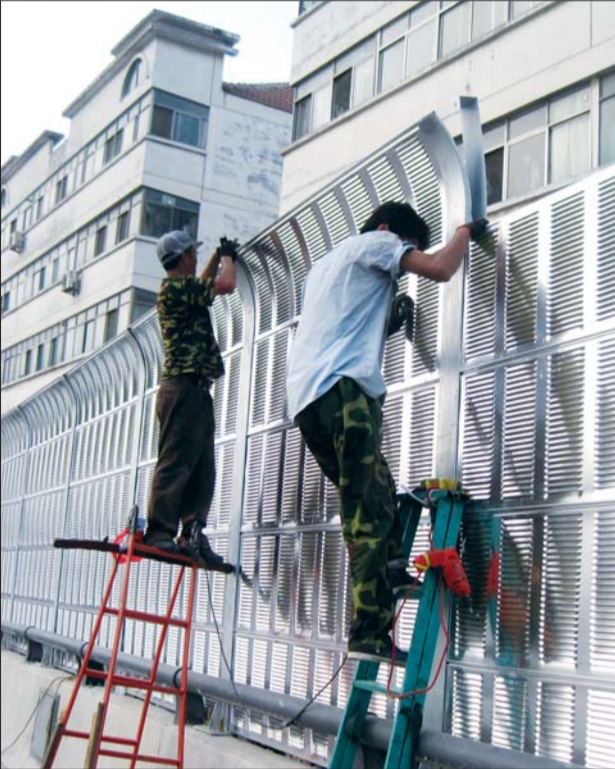
工人正安装隔音板。
