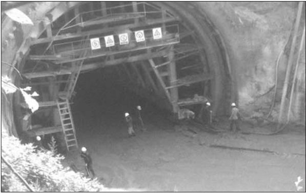
◀路面沉降点附近城际铁路隧道口淤泥外流。
