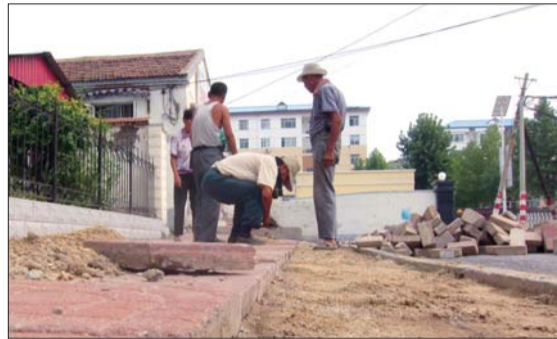
在中原街,施工人员正在铺设人行道花砖。本报记者 王金强 摄
