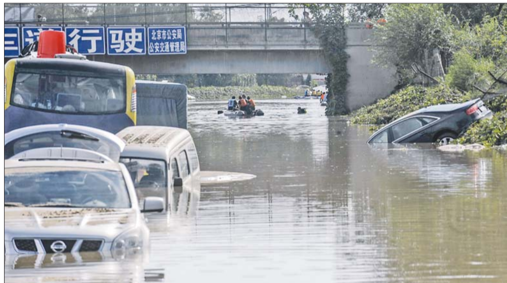
22日,北京京港澳高速公路一铁路桥下严重积水,最深处超过2米。
