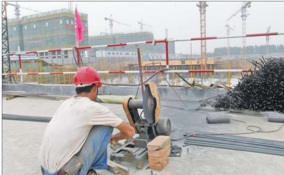
物流中心项目正在进行地下车库的施工。 本报见习记者 张颀 摄
