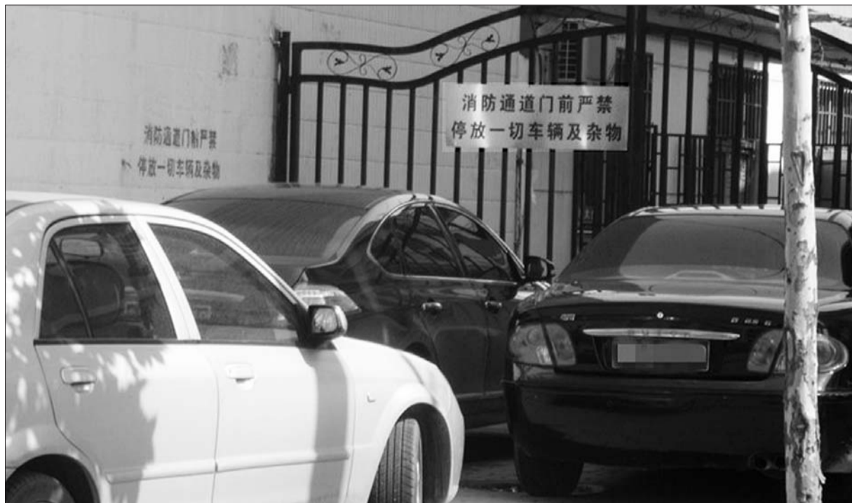
23日,德城区光明街附近的消防通道被一些私家车占据。按照相关规定,占用、堵塞、封闭疏散通道、安全出口或者有其他妨碍安全疏散行为可处罚款。本报记者 郭光普 摄影报道
