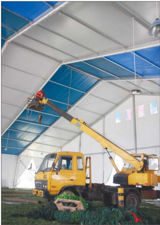
啤酒大篷内部宽敞无遮挡,可容纳吊车作业。(图片由啤酒节办公室提供)
