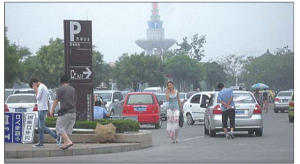
万平口风景区的停车诱导屏已安装完毕,调试无问题后将上线使用。本报记者 冷炳豪 摄
