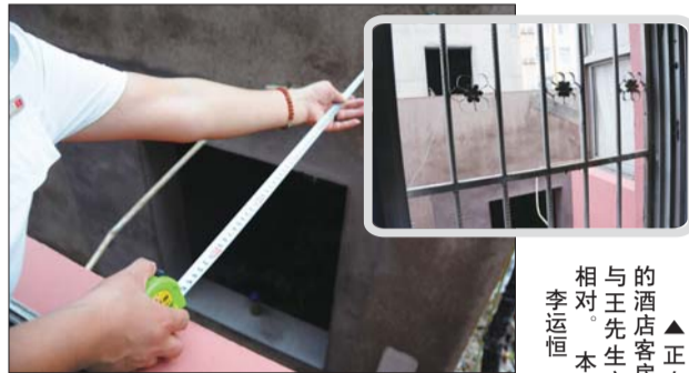
▲一位住户用尺子量一量窗户与对面客房距离,不足1.3米。本报记者 李运恒 摄
