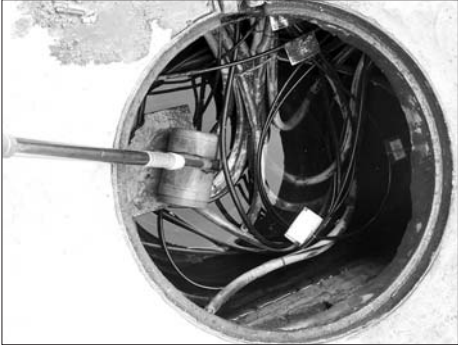
一处下水道口积水已经浸泡了电线。 本报记者 段学虎 摄 井口不少于3处。 据小区居民讲,小区内地下井口渗水已经是老问题了,该小区是一个老小区,地下输水管道有不少是铁质的,时间长了都老化了,水应该是从老化的输水管道里渗出来的。小区物业也来修过,但总是治标不治本,“我来这个小区七八年了,小区内的地下管道好像还没更换过,像这样渗水就已经很长时间了。”一位正在井口取水的居民说。 随后,记者拨打了小区居民提供的物业电话,物业工作人员说:“小区内公共场所的地下井口渗水由物业负责,我们将尽快去查看,并尽量解决。”尽管物业做出了答复,但小区居民仍对此不抱太大希望。“以前也修过,根本的解决办法是更换老化管道,现在不少严重的地方水都泡着电线,万一发生危险,后果很难想象。”一位小区居民说道。
