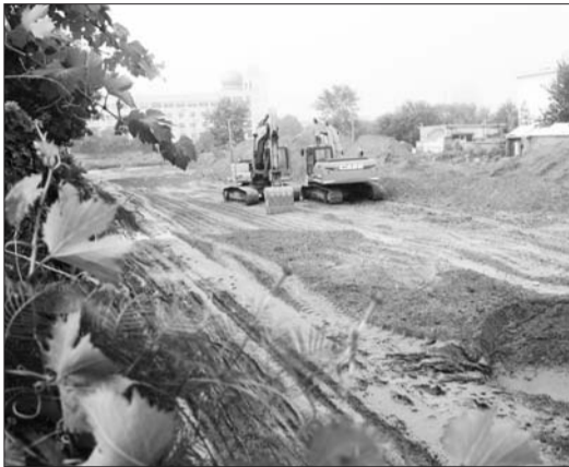
改造施工现场。本报记者 马志勇 摄
