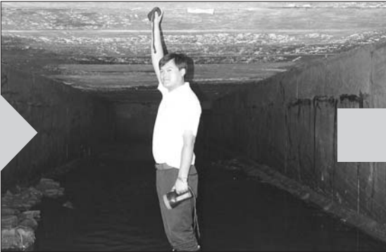
工作人员在暗渠内伸手方能触到顶部,暗渠足有两米多高。
