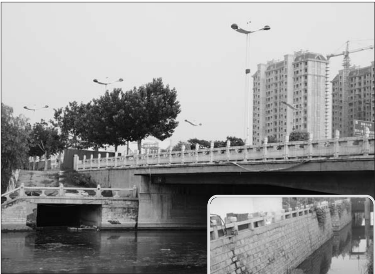
▲黄河五路新立河边4米×1.8米的排水暗渠。
