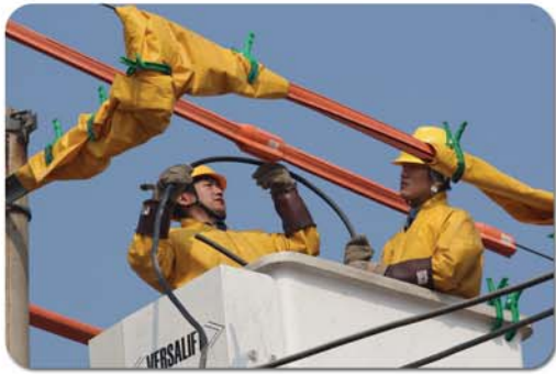
积极开展10千伏带电作业，最大限度减少城乡停电时间。 韩芳 摄
