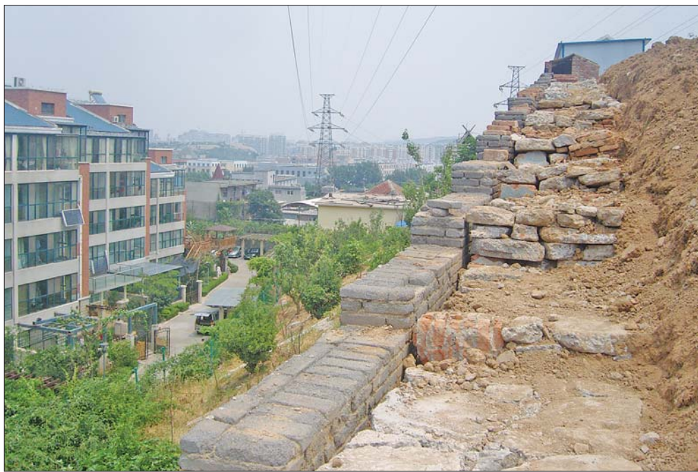
▲围墙一侧是港澳花园小区6号楼,另一侧堆满了渣土。
