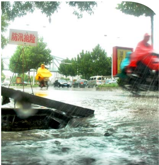
在湖滨大道上积水路段城管部门的工作人员开启井篦子进行排水。 本报记者 马志勇 见习记者 王明婧 摄影报道
